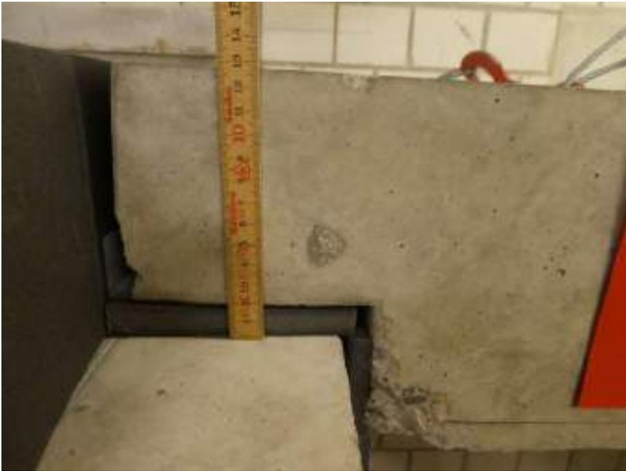
Abbildung 16: Treppenlager Egcoscal SP LS 43 kN im eingebauten Zustand (oben)
