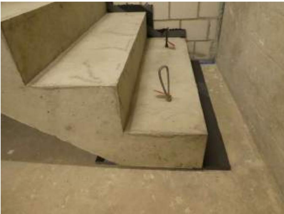
Abbildung 17: Treppenlager Egcoscal SP F-Form für Laststufe 43 kN im eingebauten Zustand (unten)
