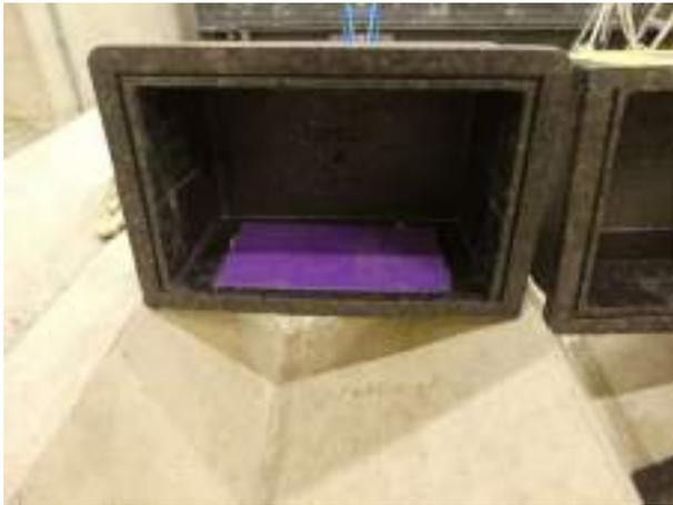
Abbildung 7: Podestlager Egcosono SP mit 15mm Elastomerlager
