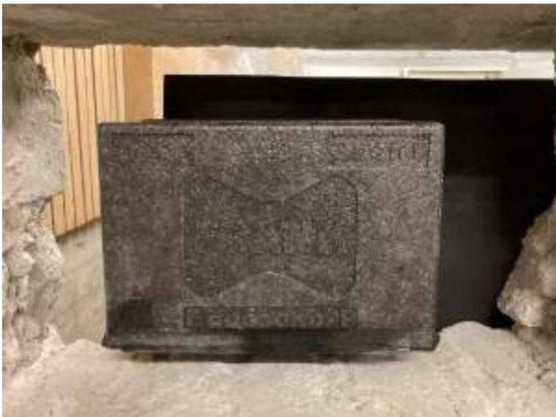
Abbildung 19: Einbausituation von Podestlager Egcosono SP mit 15mm Elastomerlager
