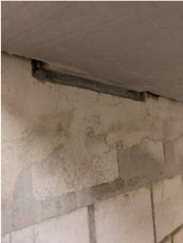
Abbildung 20: Podestlager Egcosono SP mit 15mm Elastomerlager nach fertigem Einbau,  $z = 1.5$  cm
