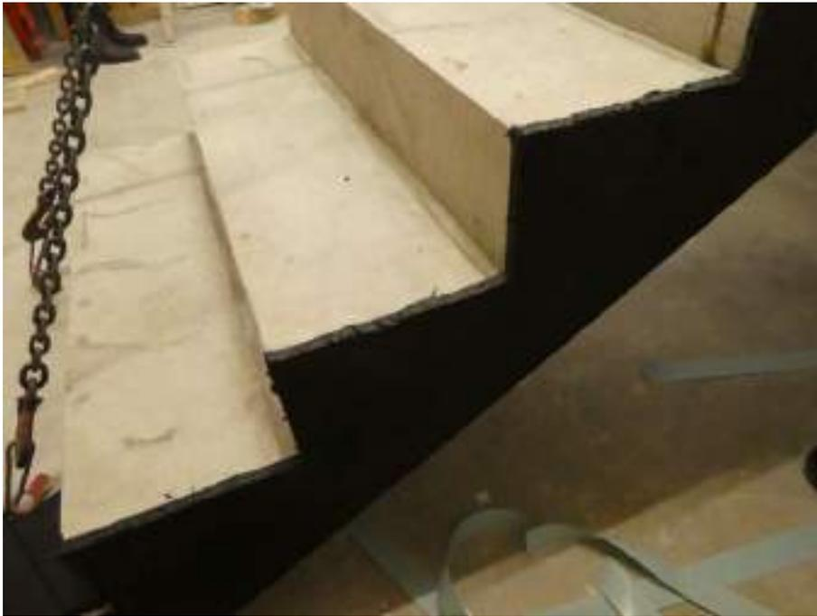
Abbildung 18: Treppenlauf mit Distanzplatte FDPL 15420 beim Einbau
