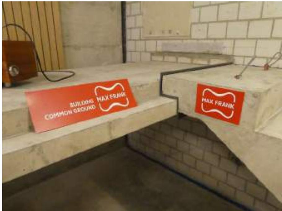
Abbildung 39: Übersicht Einbausituation Messung von Lauf-Trittschallpegel
