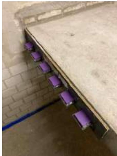
Abbildung 4: Detailansicht Auflager vom Treppenlager Egcostep SP mit 15mm Elastomerlager, Ausführung Typ S6
