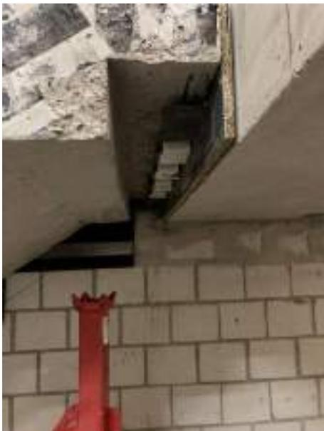
Abbildung 6 Treppenlager Egcostep SP mit 15mm Elastomerlager, Ausführung Typ S4, Auflager oben
