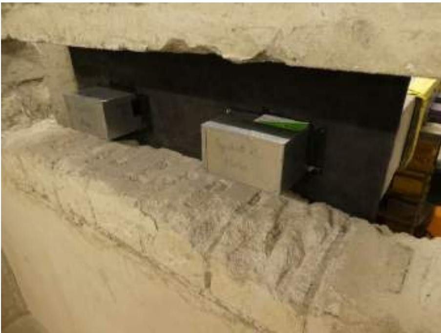
Abbildung 21: Podestlager Egcopal SPX mit 15mm Elastomerlager beim Einbau
