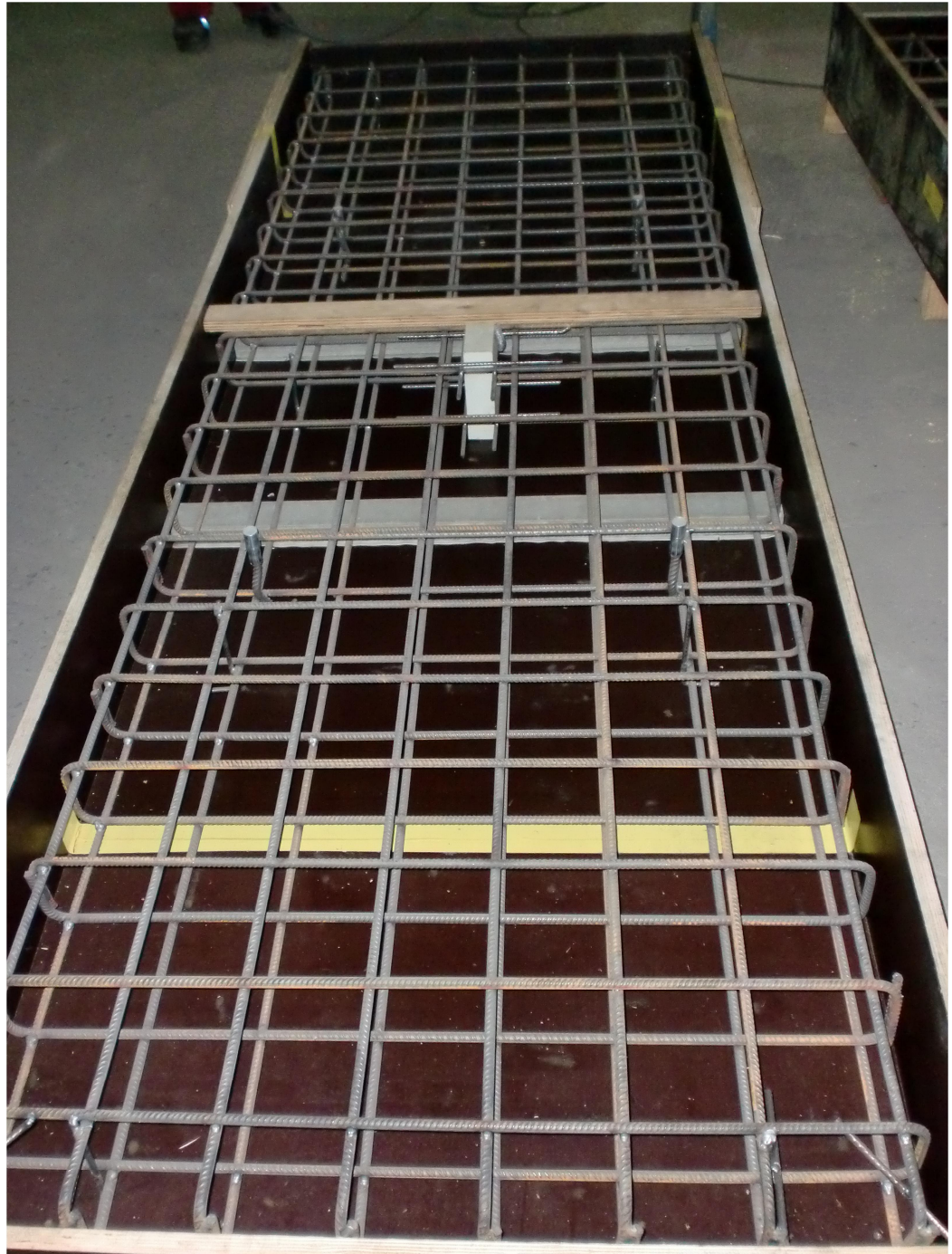
Bild 4 Versuchskörper mit Sorp10 vor der Betonage
