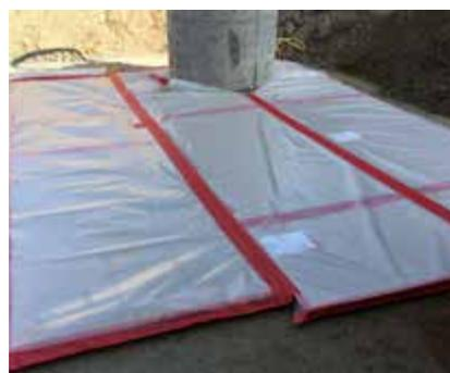
Als zusätzlicher Feuchtigkeitsschutz für die Egcovoid® Setzungsplatte kann ein Folienschlauch über jede Plattenreihe gezogen werden. Die Enden des Folienschlauchs werden mit dem Klebeband abgedichtet.
